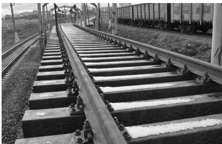
Рисунок 5 – Композитные шпалы из пластика вторичной переработки производства компании "АКСИОН РУС"
