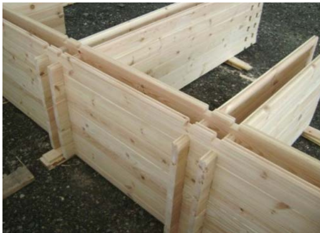
Рис. 1. Конструкция дома из двойного бруса
