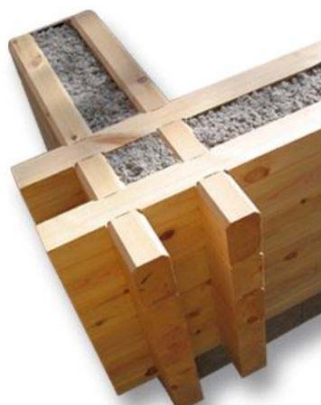
Рис. 2. Стена с утеплителем эковатой
