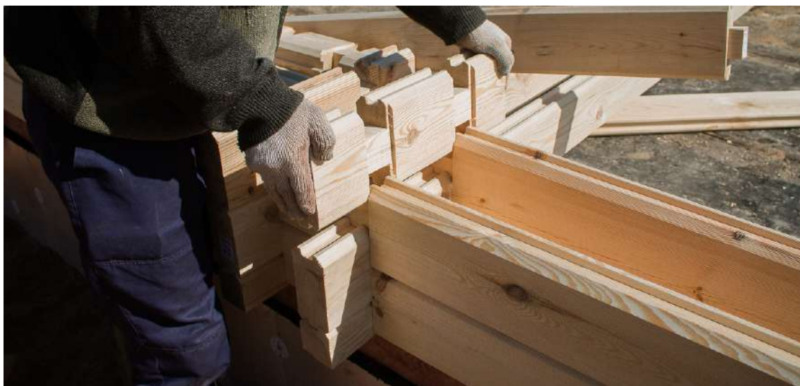
Рис. 1. Конструкция двойных стен с перерубами
