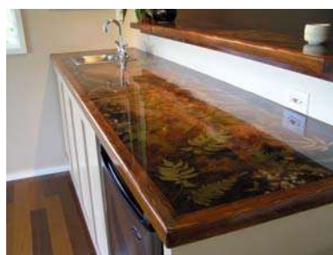
Рис. 1. Столешница, выполненная методом заливки декоративных элементов [4]
