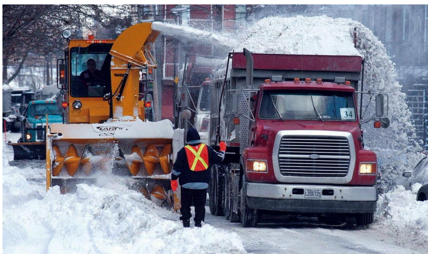
Рисунок 1 – Очистка от снега дорог в США
