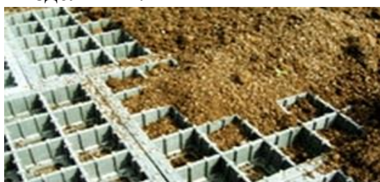
Рисунок 7 – Засыпка грунтом газонной решетки
