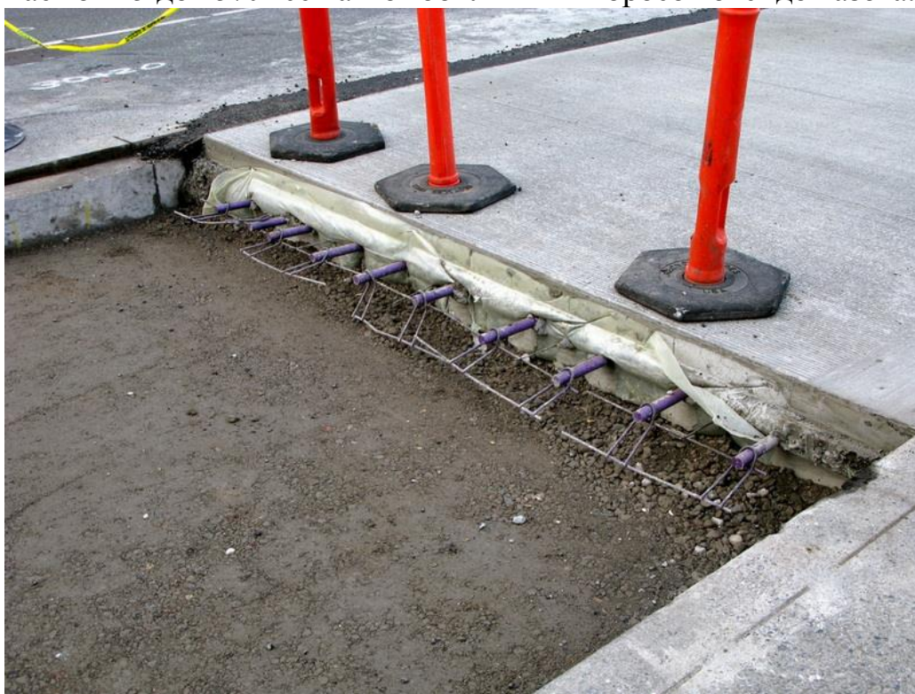
Рисунок 2 – Сооружение автодорожного полотна
