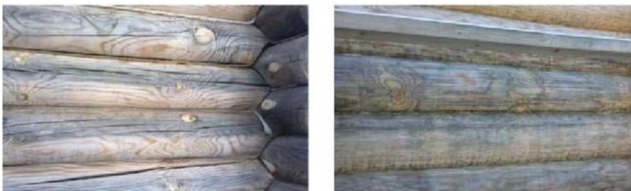
Рисунок 2 – Изменение цвета изделия изготовленного по разным технологиям через определённый срок эксплуатации
