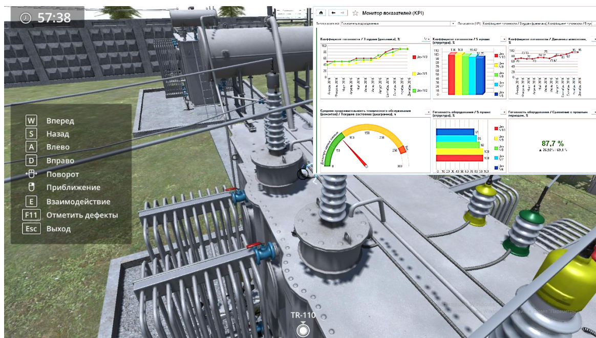
Рисунок 3 – Окно работы с отображением данных датчика на тяговом трансформаторе
