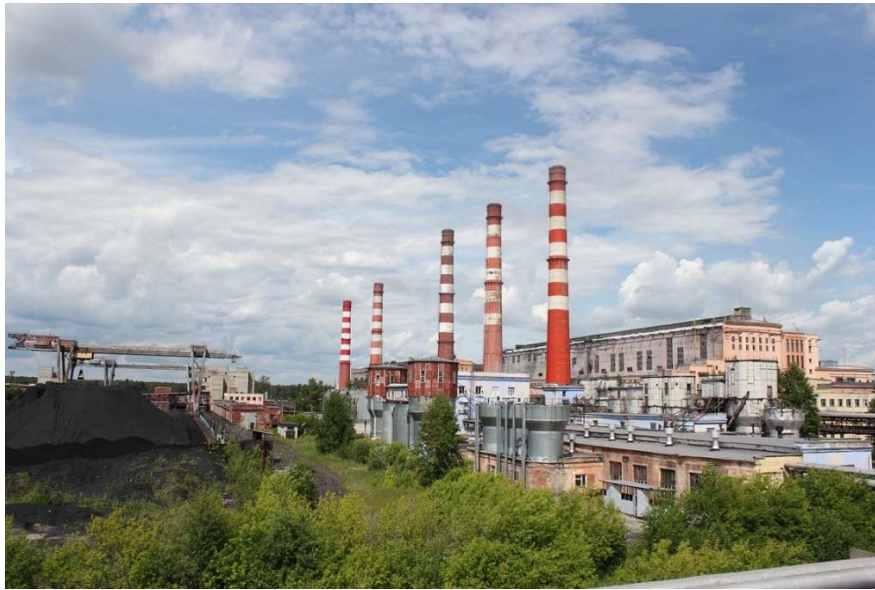
Рис. 1. Общий вид ТЭЦ г. Северск, Томская область.
