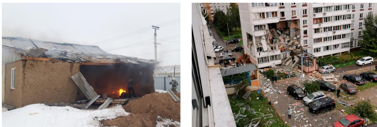
Рисунок 3. - Последствия взрыва газового баллона
